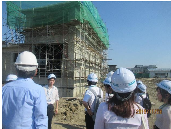
11月28日【ODA視察】 バゴー橋建設事業
