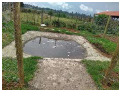
完成したため池
