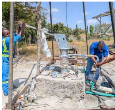
手押しでの揚水確認
