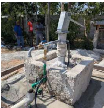
電動での揚水確認
