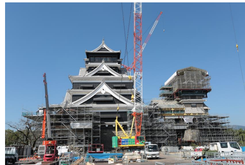
復旧工事中の熊本城
