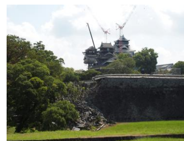
復旧工事中の熊本城
