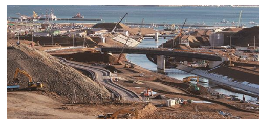
復興工事の様子
