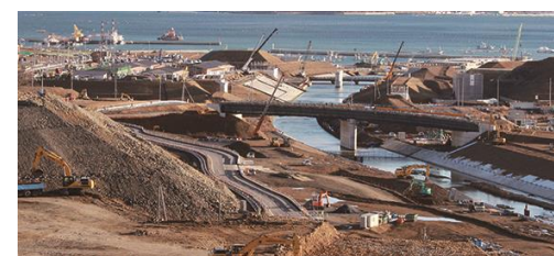
復興工事の様子
